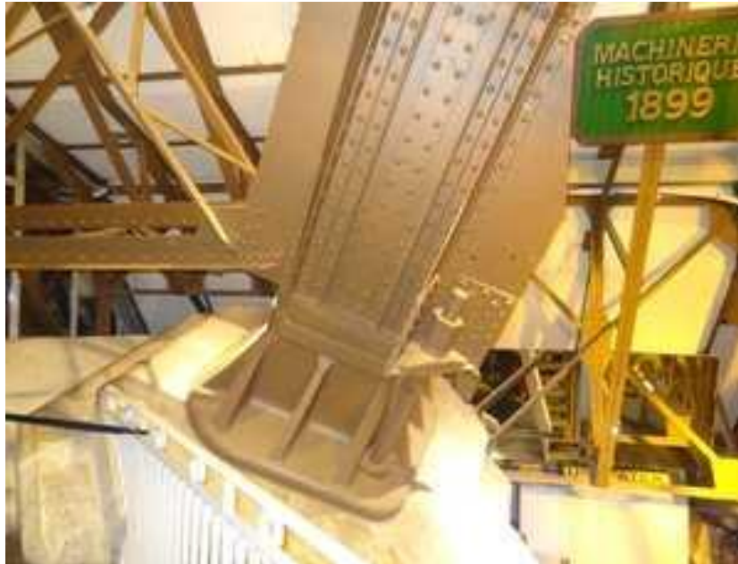
Le point de jonction arbalétrier-maçonner
